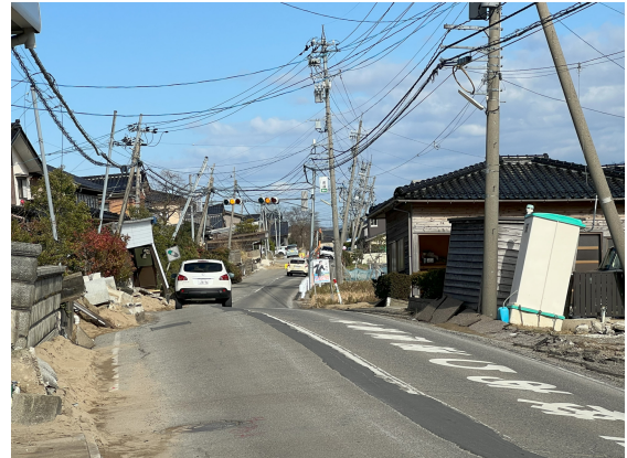
写真2 内灘町西荒屋の被災状況
