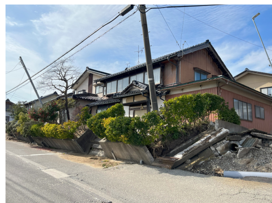
写真4 内灘町の西荒屋の建物被災例
