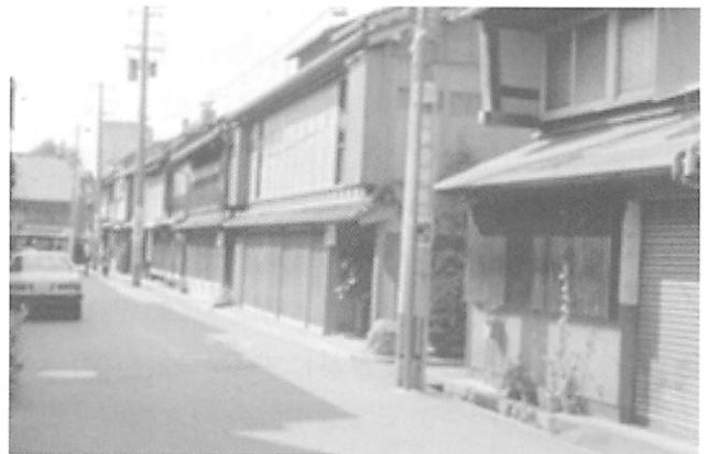
写真3 東茶屋街の改修建物 (軒裏にモルタル壁やドレンチャーの配管が見える)
