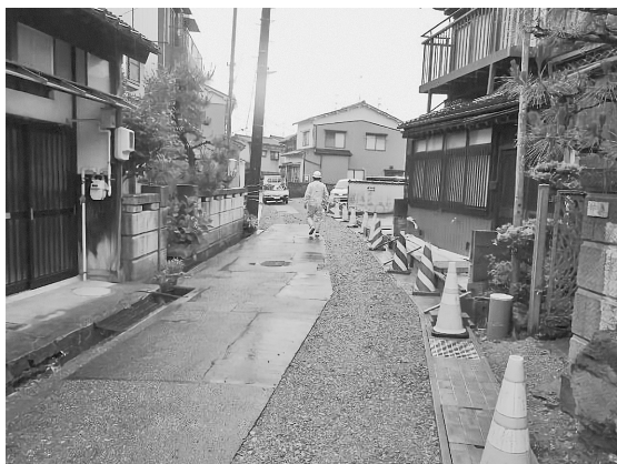
写真1 森山地区における防災道路の整備
