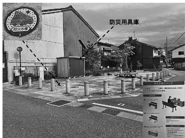
写真2 森山地区における防災広場と地下防火水槽の整備
